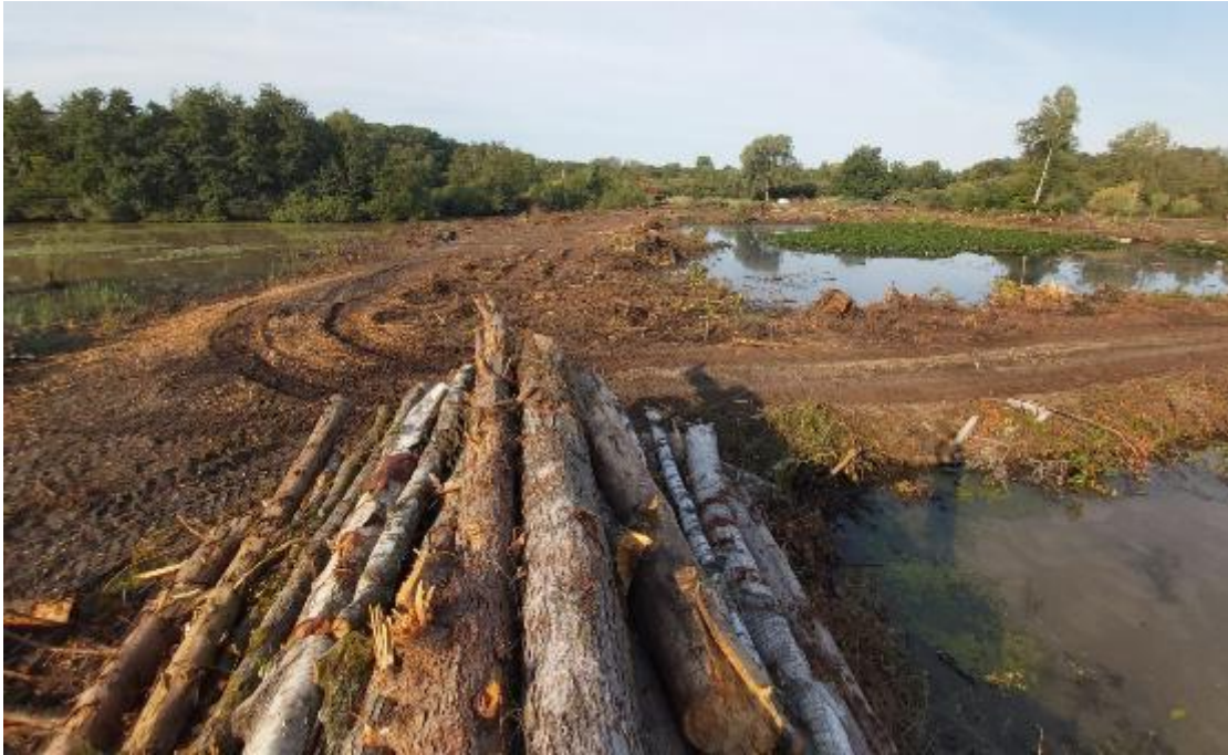
Figuur 17 Impressie tijdens inrichtingswerken 2022. Verwijderen vegetatie en dijken afgraven.
