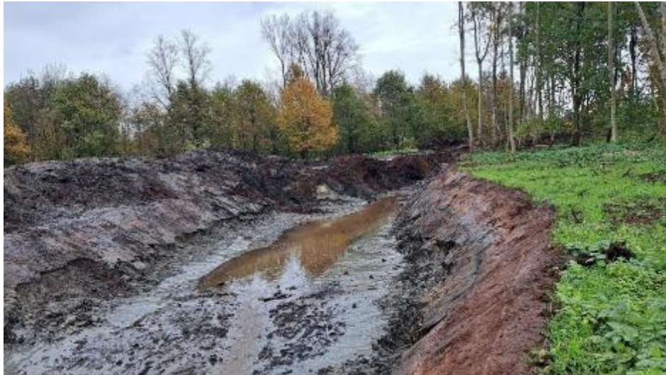
Figuur 8 Rivier Aa in Graafweide-Schupleer tijdens de uitvoering van het hermeanderingsproject
